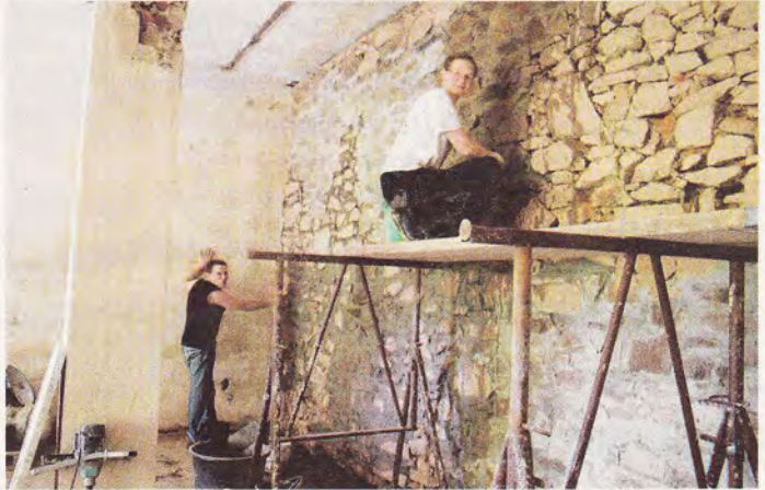
Franziska und Christian beim Verfugen in der Scheune. Draußen sind derweil Timo und Oliver an einer Bruchsteinmauer beschäftigt. Auf dem Scheunendach entfernen André und Katharina Wildwuchs.
