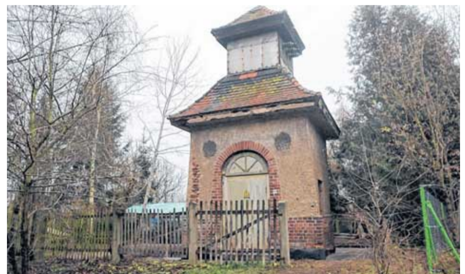
Soll aufgehübscht werden: Das Trafohäuschen unweit der Schaddelmühle wird vom Förderverein in diesem Jahr saniert. Fotos: Andreas Röse
