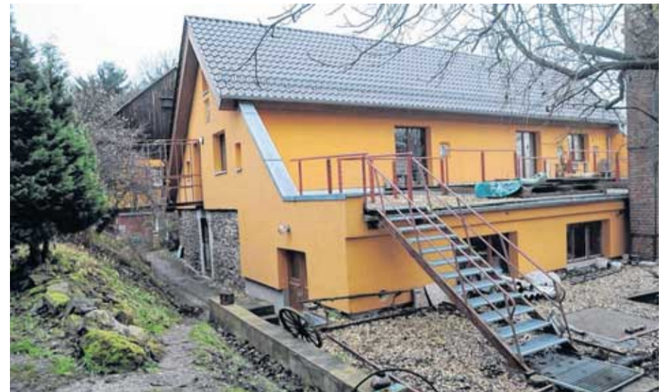
Einst Wassermühle, heute Künstlerhaus: Nach dem jüngsten Hochwasser soll die Heizungsanlage auf der höher liegenden Terrasse platziert werden.
