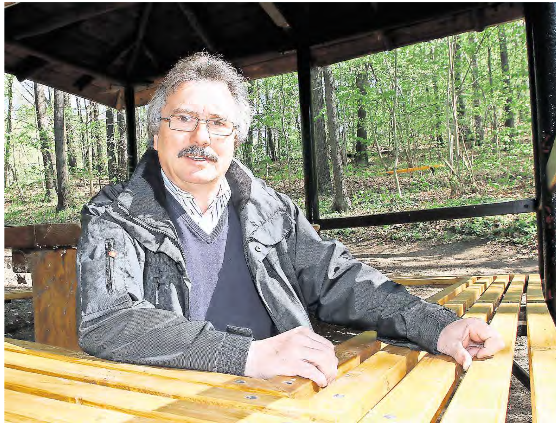
Ralf Sachse an der Rausche. Derzeit ist jedoch die Böschung des Baches beschädigt. Diese soll gestützt werden.
